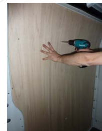
Placez & vissez le côté AV gauche 11 vis 4x30
