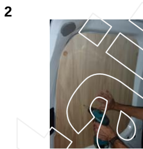
Placez & vissez le côté AR Gauche 6 vis 4x25
