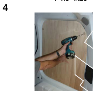
Placez et vissez le côté AR Droit 6 vis 4x25
