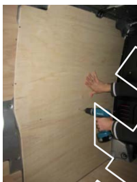
Placez & vissez le côté AV Gauche 10 vis 4x25
