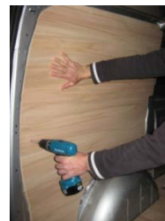
Placez & vissez le côté AR Gauche 12 vis 4x25
