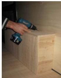
Placez et vissez le passage de roue Droit 6 vis 4x30
