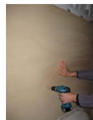
Placez & vissez le côté AR Gauche 12 vis 4x25
