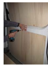
Placez et vissez la porte latérale Parties haute & basse 12 vis 4x25
