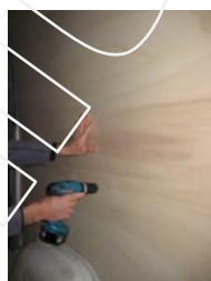
Placez et vissez le côté AR Droit 12 vis 4x25
