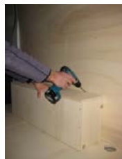
Placez et vissez le passage de roue Droit 7 vis 4x30
