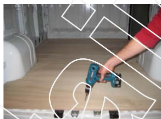
Placez & vissez le Plancher AR 7 vis 4x25
