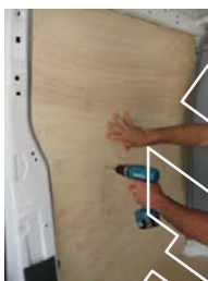
Placez & vissez le côté AV Gauche 9 vis 4x25
