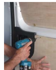
Placez et vissez la porte latérale Haut & Bas 10 vis 4x25
